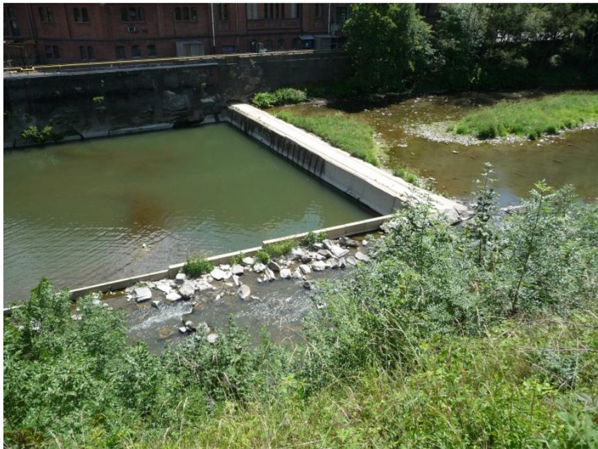
Bild 5-1: Fischaufstiegsanlage an der Wehranlage Lenne 1, Foto: Märkischer Kreis
