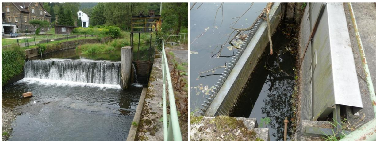
*Bild 2-4: Wehranlage (links) und Einlaufrechen (rechts) des Ausleitungskraftwerkes Bärenstein an der Ver-se, Fotos: Märkischer Kreis*
