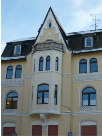
Beispiel für einen Zwerchgiebel in Verbindung mit einem Erker.
