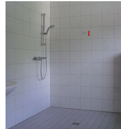
Bodengleiche Dusche in einer Neubaumaßnahme (Quelle: GBS Wohnungsbaugesellschaft mbH, Menden)
